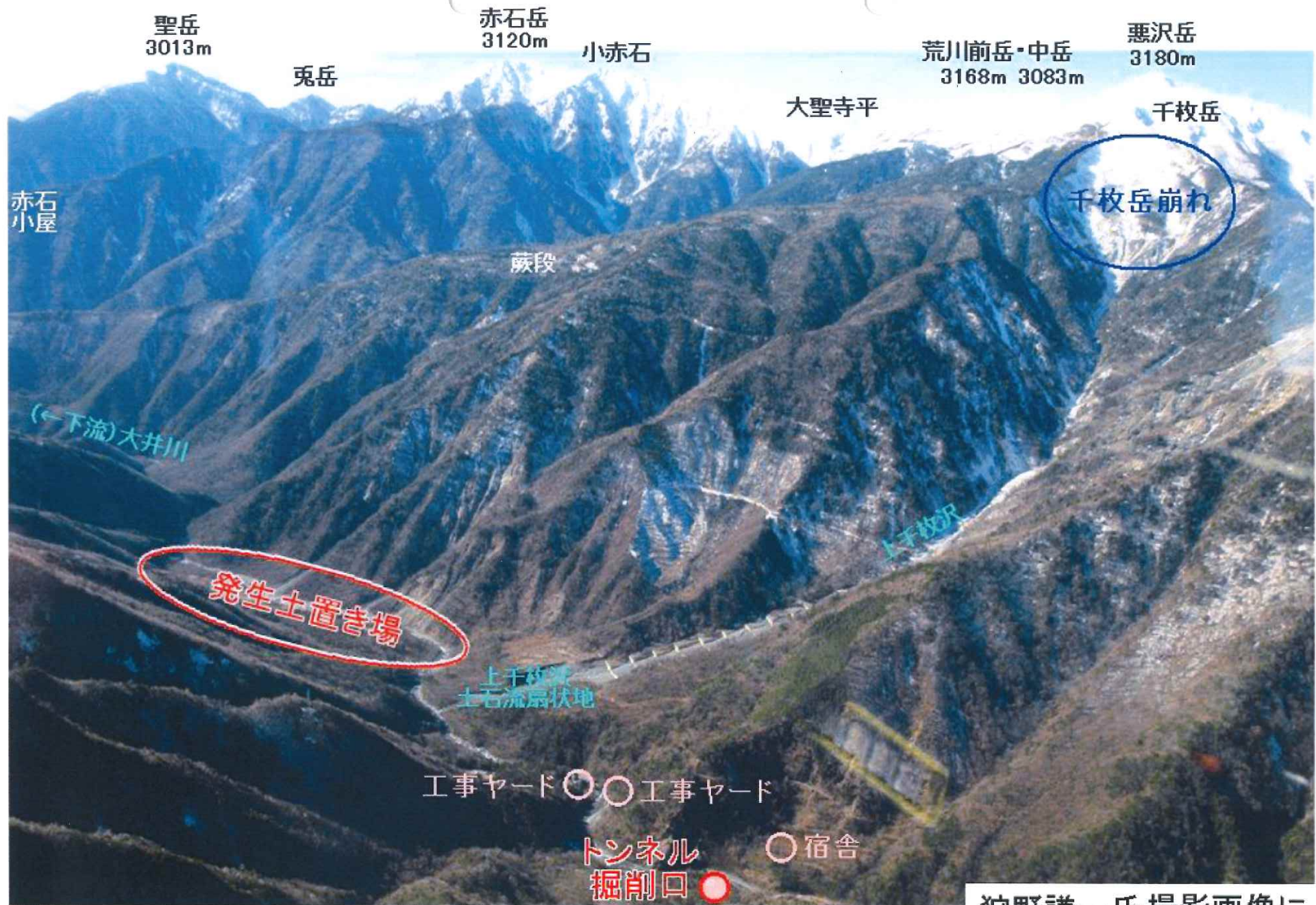
大井川源流のリニア新幹線トンネル掘削口と発生土置き場（燕沢）
